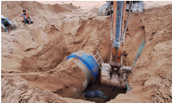
Algunas de las fugas identificadas
