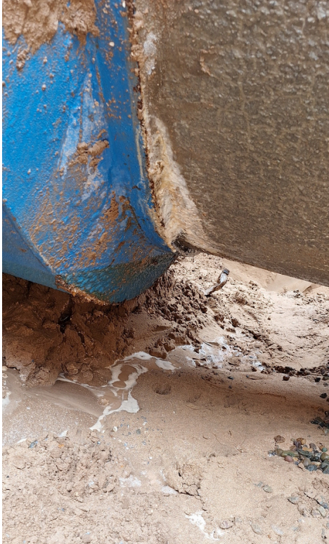
Algunas de las fugas identificadas
