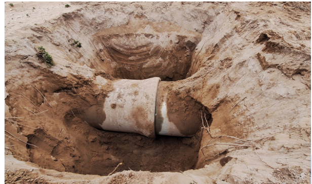
Algunas de las fugas identificadas
