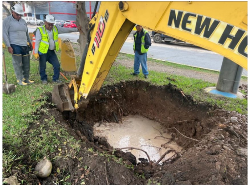
Excavación de la principal fuga identificada
