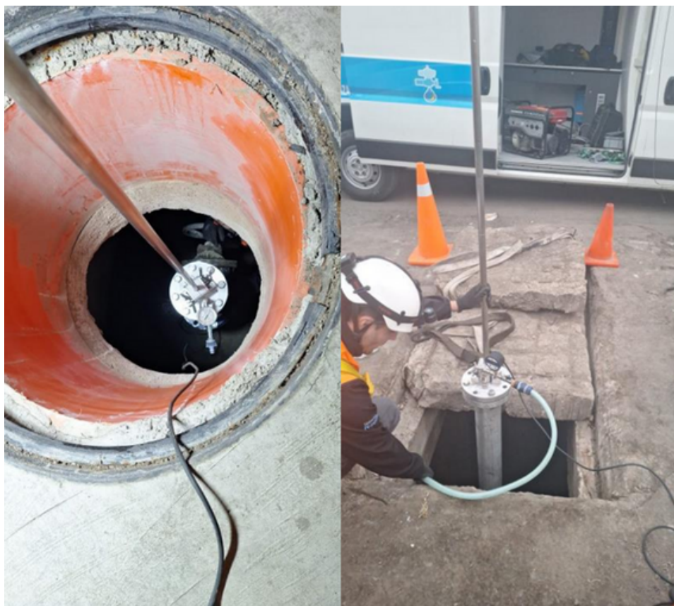
Instalación del sistema de inserción (izquierda) y del sistema de extracción (derecha)
