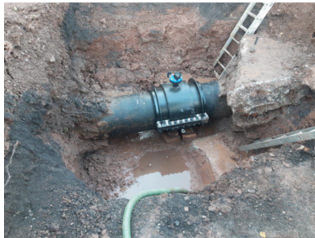
Exposición y reparación exitosa de la fuga F1 en base a las coordenadas proporcionadas por Aganova.
