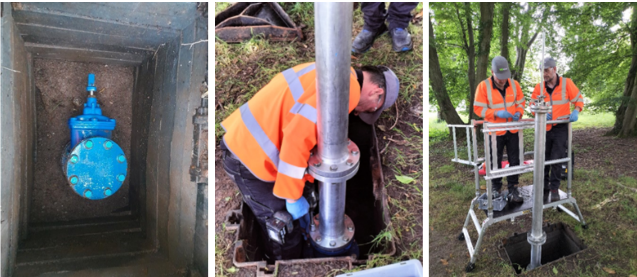
Extracción de la esfera Nautilus mediante un sistema de recuperación no invasivo montado en válvula DN150.
