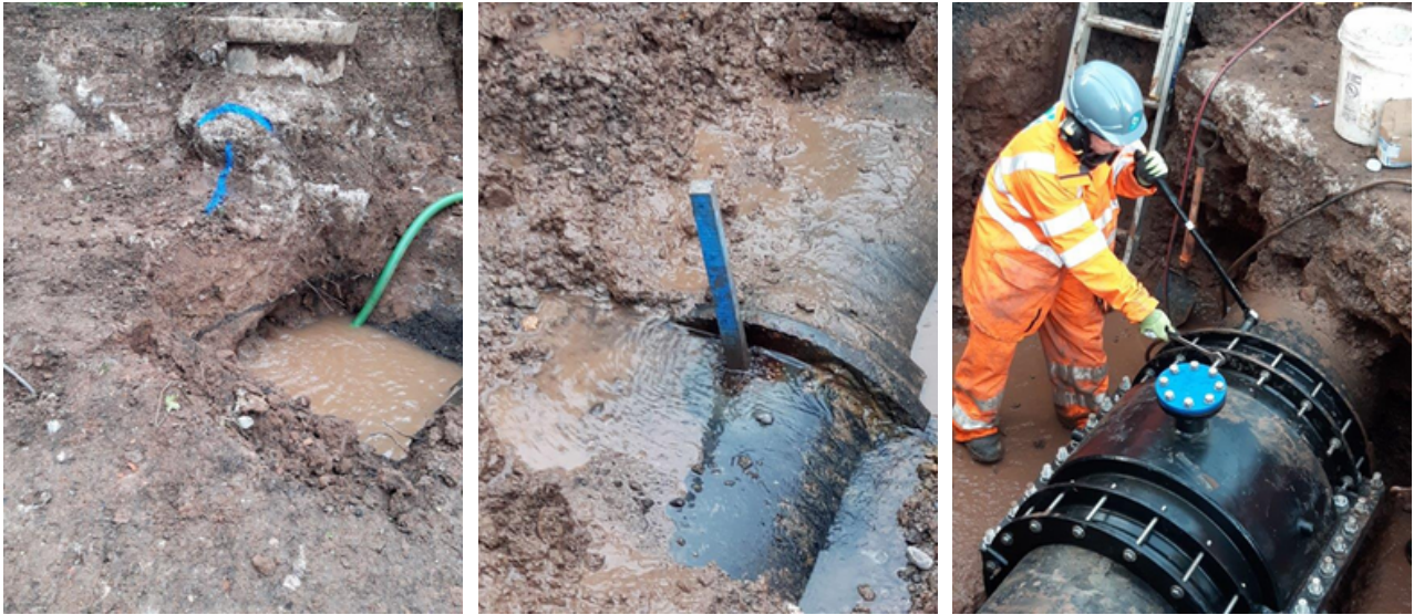
Exposición y reparación exitosa de la fuga F1 en base a las coordenadas proporcionadas por Aganova.
