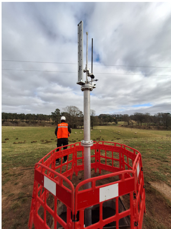
Instalación de la red de extracción
