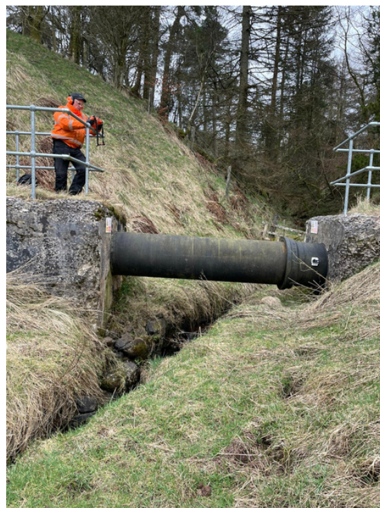
Tramo de la conducción de agua bruta por gravedad inspeccionada entre Baddinsgill y Pateshill
