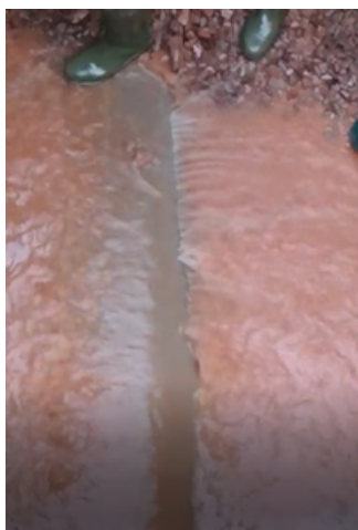
Excavación en el punto de fuga
