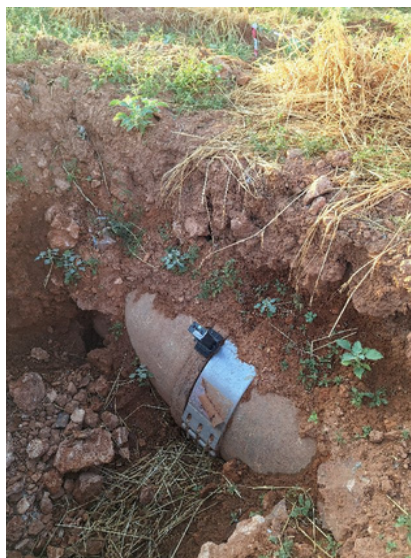
Instalación de sincronizadores.
