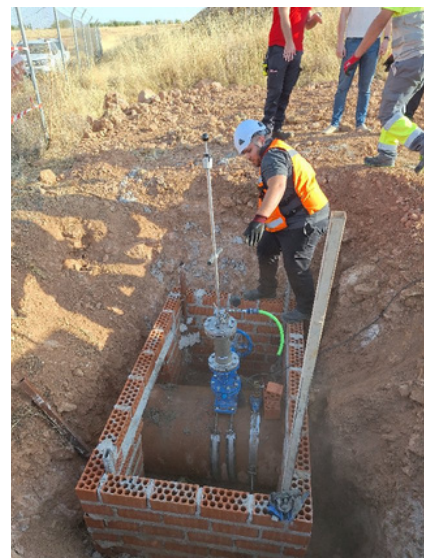
Instalación del sistema de inserción.
