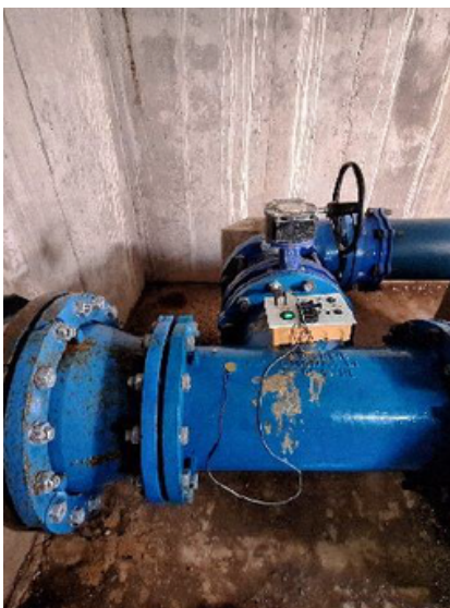
Revisión del Punto de extracción.
